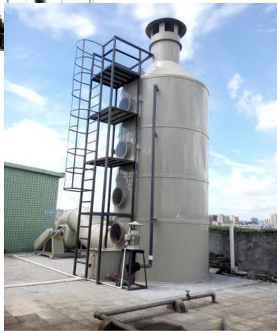
振興展業膠袋（深圳）有限公司是一家包裝袋生產企業，擁有各類膠袋生產設備。2016年獲清潔生產伙伴計劃示範項目資助下，振興安裝化學洗滌有機廢氣淨化系統，以減少印刷工序產生之揮發性有機化合物排放（示範項目編號：16D0478）。
